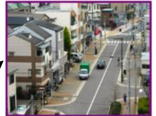
都市計画道路 (河堀口舍利寺線) 平成17年3月・平成23年9月 一部完成 (延長210m)
