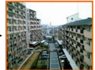
都市再生住宅 (生野東住宅11・12号館) 生野東住宅第1期 平成11年3月 完成 (85戸) 生野東住宅第2期 平成14年4月 完成 (40戸)
