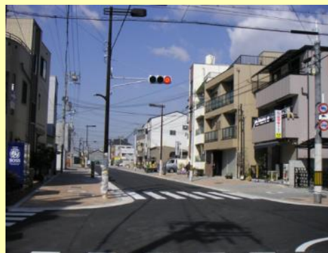
用地を取得し、整備工事を実施
