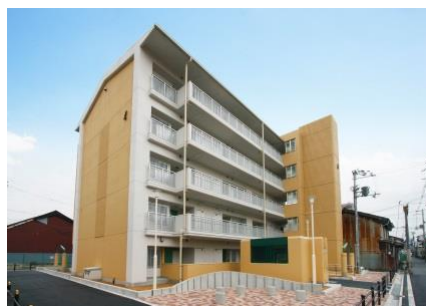
② 改良住宅(H20 築)
