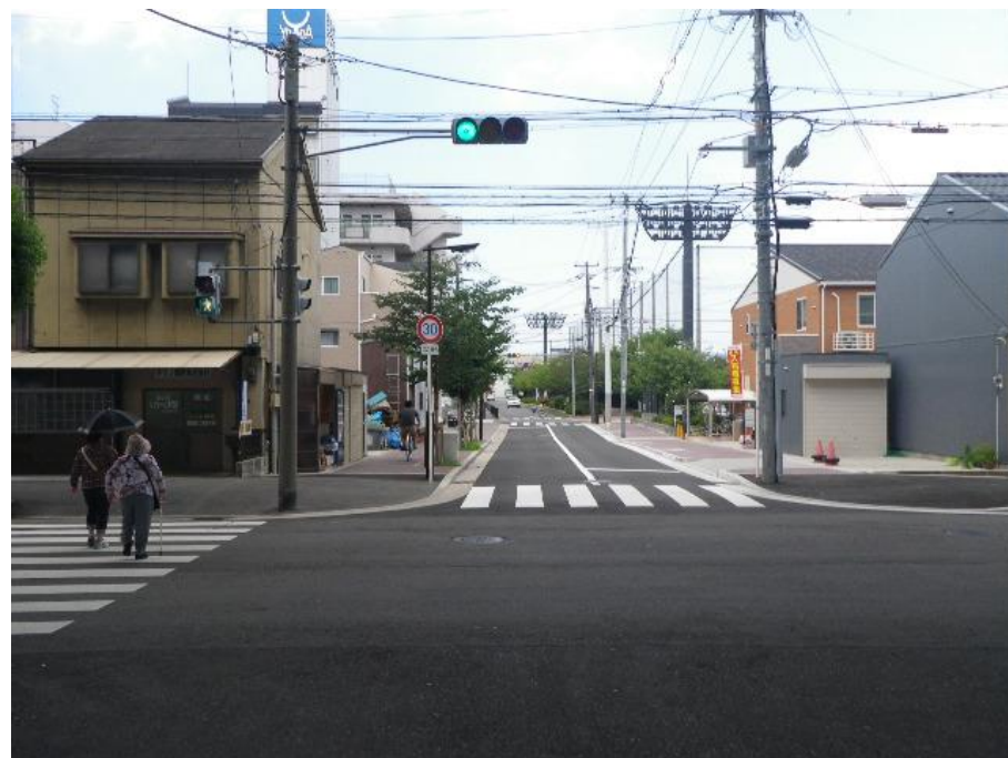
整備完了後(平成23年)
