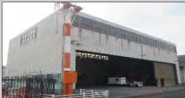
格納庫外観（裏側に事務室あり）
