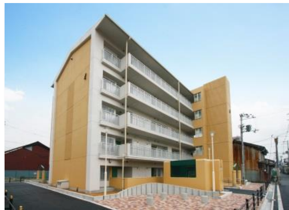
本市の改廃住宅
