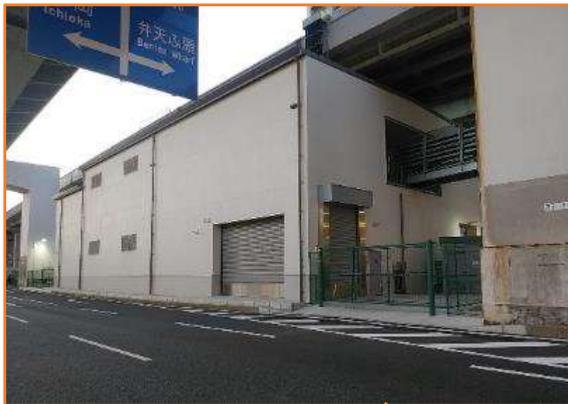
令和元年11月 新変電所供用開始
