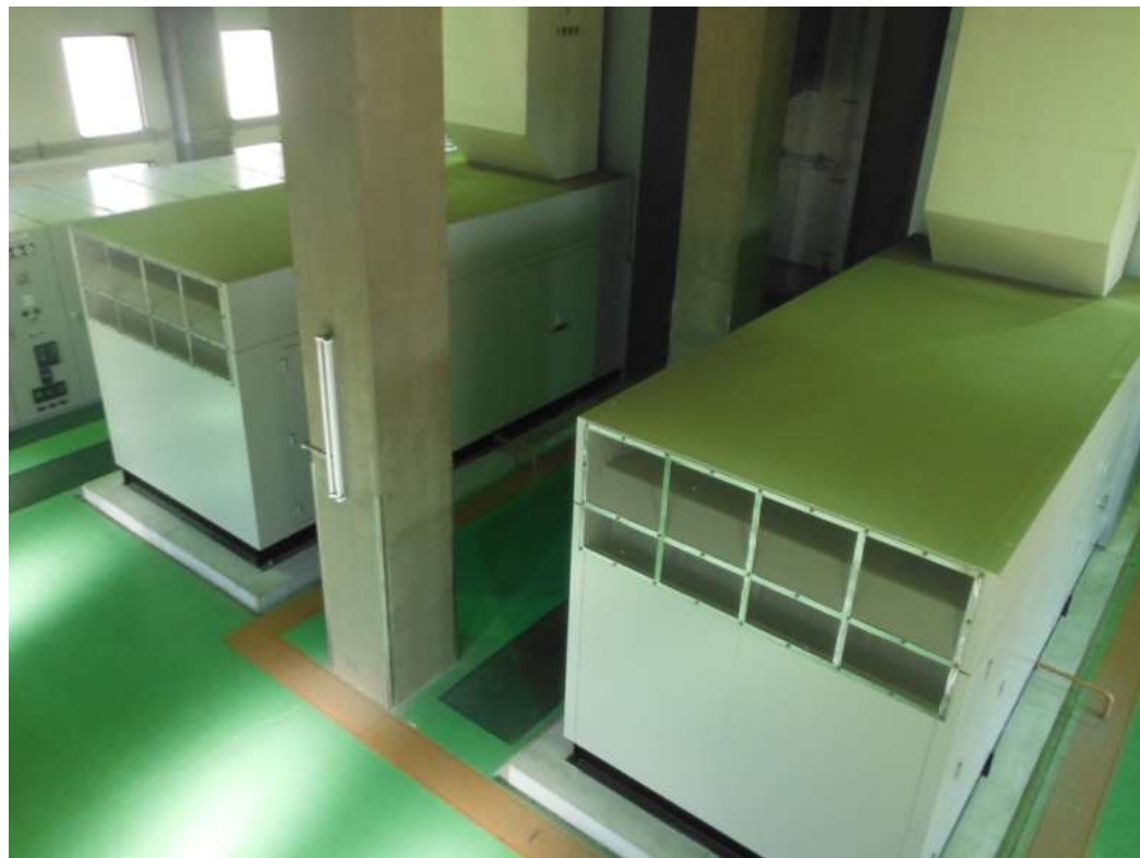
(柴島浄水場上系施設運転用自家発電設備)
