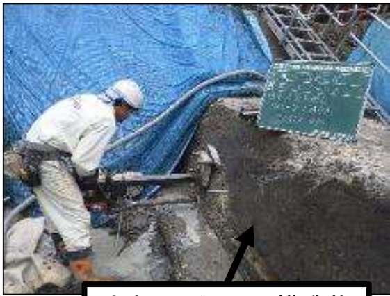
地中コンクリート構造物
