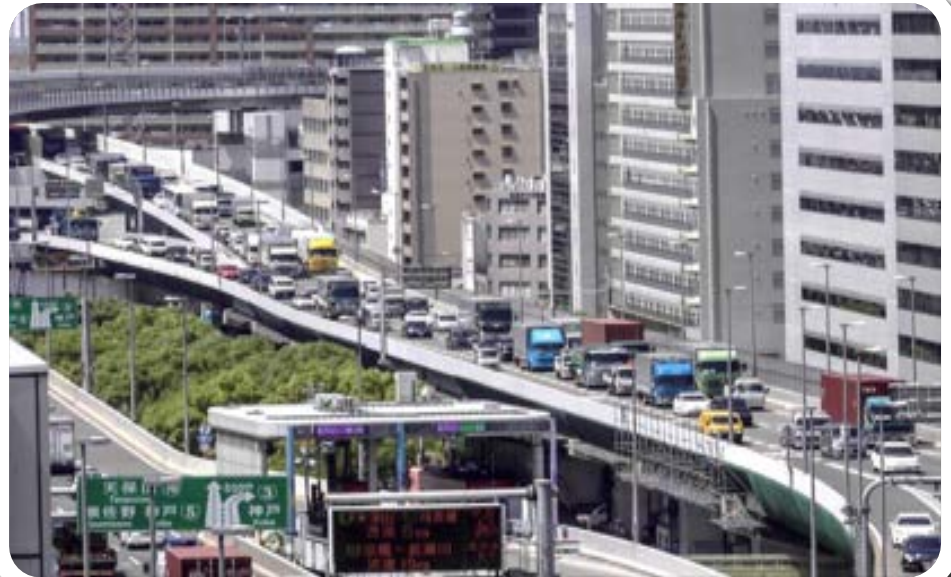
写真：阪神高速道路（阿波座合流部）
