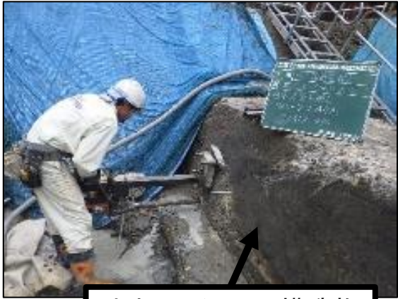
地中コンクリート構造物
