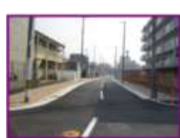
主専生活道路（生野東西線） 平成25年3月・平成26年3月 完成（延長約300m）
