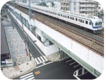
(整備事例: 南海本線(篠芝-玉出間)連続立体交差事業)
