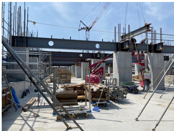
建設現場 (中百舌鳥 工学棟)
