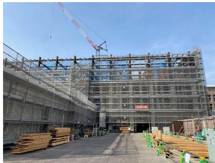
建設現場 (杉本 理学棟)
