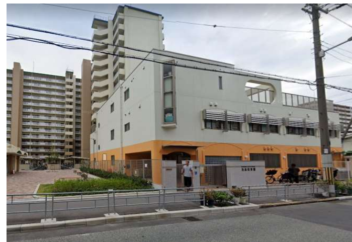
建替余剰地を活用した保育所の整備
