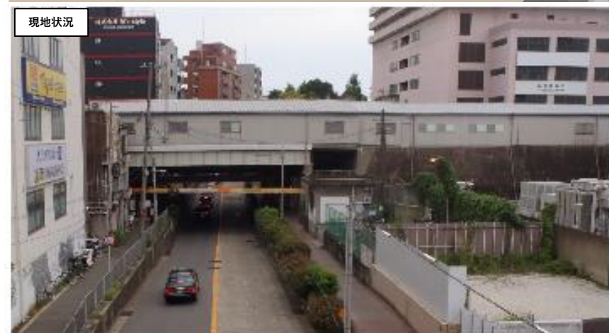
JR環状線と市道片町茨田線 交差点（西側より）
