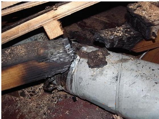
大阪市火災予防条例では、無煙ロースターの排気ダクトを設置する場合は、可燃性の部分との間隔を 10 cm以上確保するか、ダクトを不燃材料（厚さ5 cm以上の金属以外の不燃材）で被覆することと規定されています。
