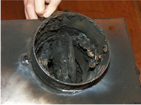
防火ダンパがクリップ留めされていたり、油脂等で固着していると、温度フューズが溶断しても正常に閉鎖せず、ダクト内に炎が進入します。
