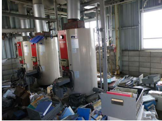
ボイラー等の一般取扱所の 津波による被災状況 (出典：消防庁)
