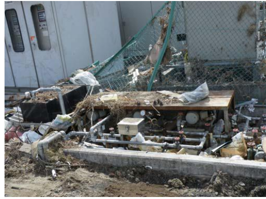
ポンプ設備の津波による被災状況 (出典：消防庁)
