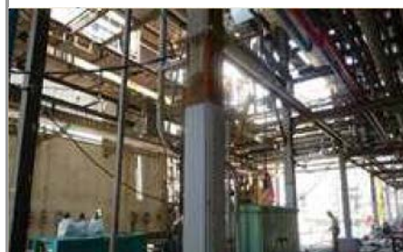
柱に 12～19mm 鋼板を 溶接補強
