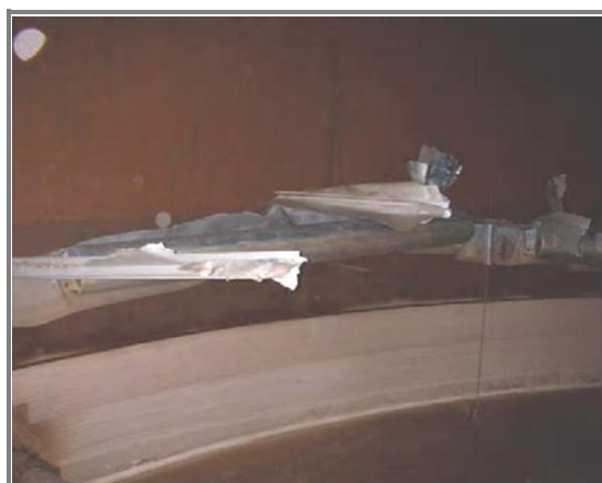
スロッシングにより破損したタンク 側板付近の浮き蓋の損傷状況 (出典：消防研究センター)
