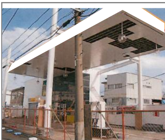
地震によりパネルが落下した建築物 (出典：仙台市消防局)
