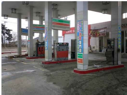
固定給油設備が欠損したアイランド (出典:危険物保安技術協会)
