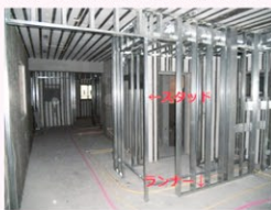
アルミ製軽量鉄鋼材LGS工法(例)
