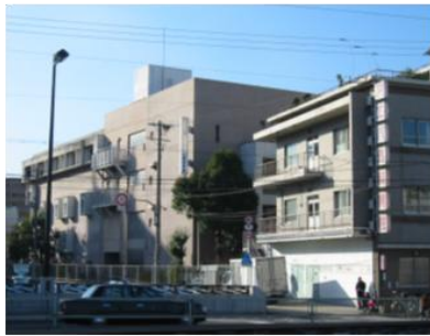
左側 大阪市立生野図書館 （1階研修室） 右側 アエバ外科病院
