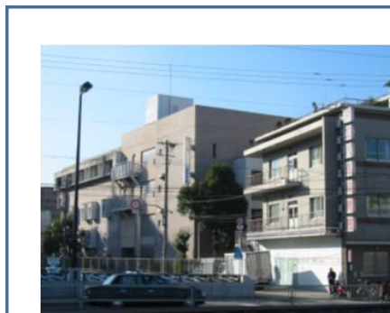
左側 大阪市立生野図書館 （1階研修室） 右側 アエバ外科病院
