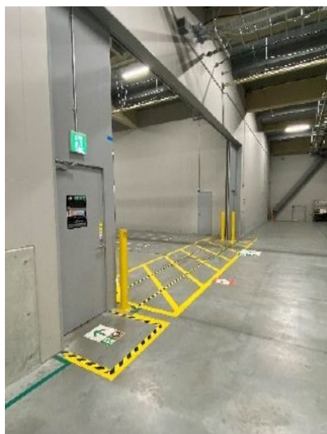
実例(4)キ：防火シャッターの降下空間及び防火戸周囲に物品を置いてはいけないことをテープにより明示
