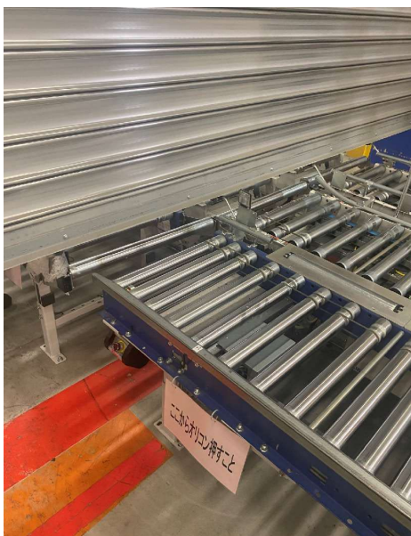
実例(8)ウ：コンベアの連動設備の点検
