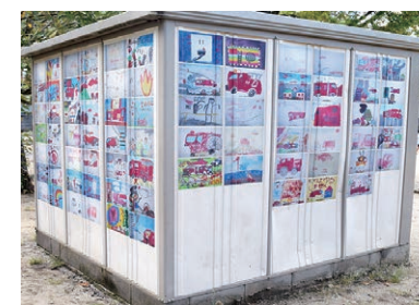
完成したPR可搬式ポンプ庫
