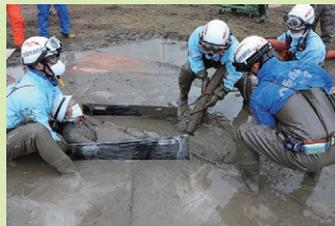
要救助者付近の吸引作業。周囲を鉄製の板で囲い内部を吸引。
