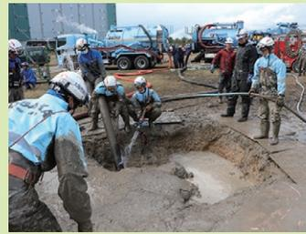
下部1mに埋没した要救助者救出のため吸引作業を継続し、縦3m、横4m、深さ1mの範囲で約10m<sup>3</sup>程度の土砂を吸引。活動開始から約1時間後(1人目救出から40分後)に2人目の救出が完了。
