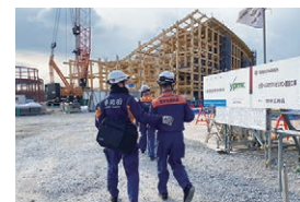
中間検査の様子
