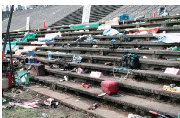
福知山花火大会火災現場の状況
