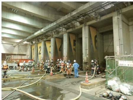
ごみ投入扉付近での活動状況
