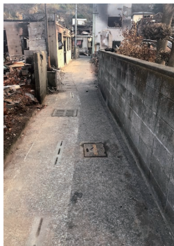
消火栓（地下式）
