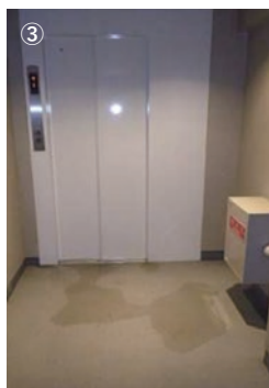
①スレート屋根の破損 ②パティションの破損 ③エレベーター昇降口漏水
