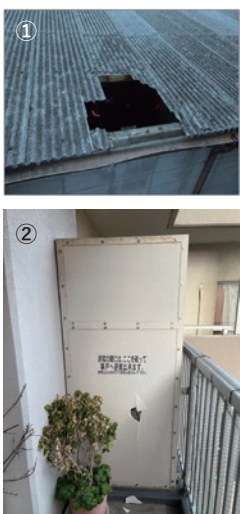
①スレート屋根の破損 ②パティションの破損 ③エレベーター昇降口漏水
