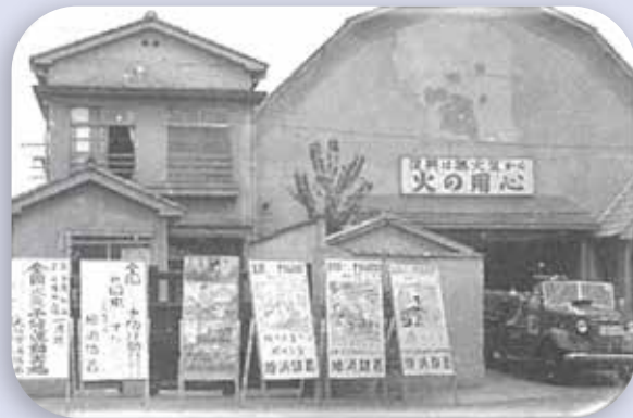
●旭消防署と望楼(1948年(昭和23年)竣工)
