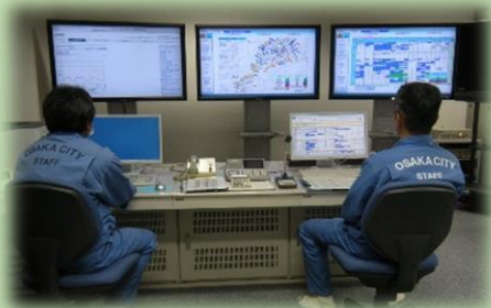
防潮扉と水門の集中監視
