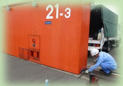
防潮扉の点検・補修
