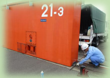
防潮扉の点検・補修
