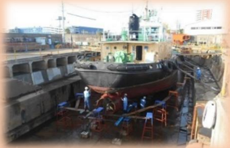
船舶の点検・修繕
