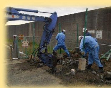
フェンスの建て替え
