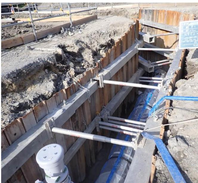
守口市への送水管 700mm布設工事（φ700×50m ダクタイル鋳鉄管）
