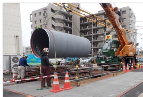
巽送水管の更新状況
