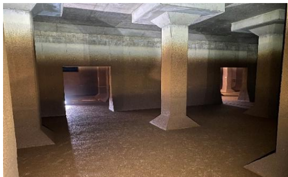
柴島浄水場 12～15 号配水池内部 (補強工事前)
