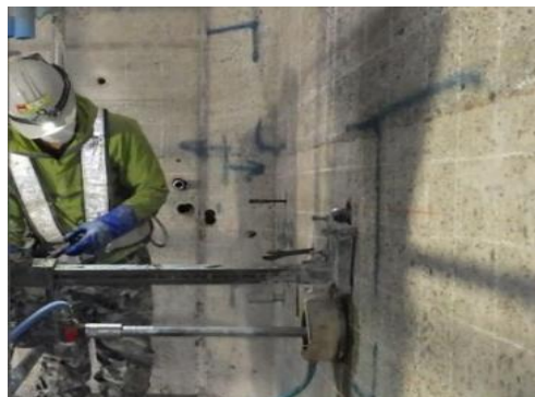
補強工事の施工事例 (あと施工せん断補強工法)
