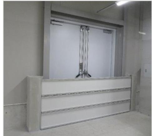
施設の耐水化（止水板の設置）
