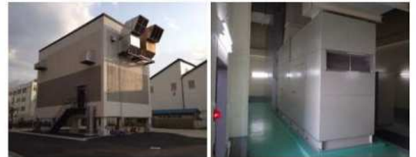
施設運転用自家発電設備
