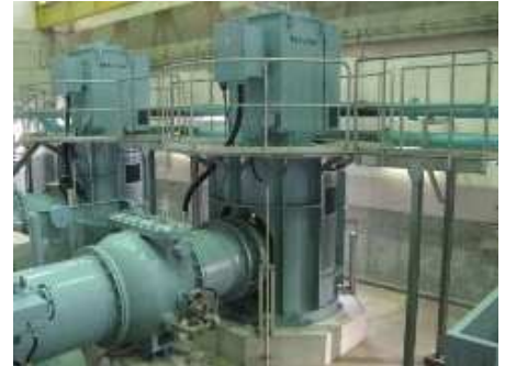
揚水ポンプ（豊野浄水場）
