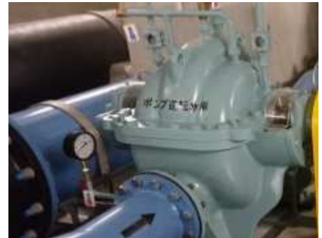
小水力発電設備（咲洲配水場）
