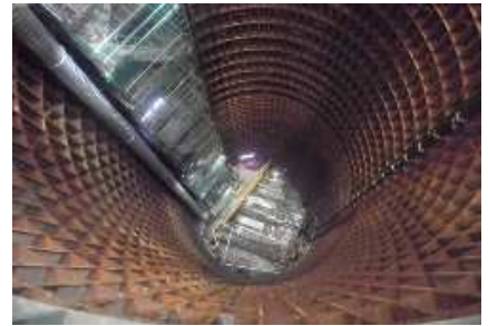
浪速枝管シールド立坑状況
