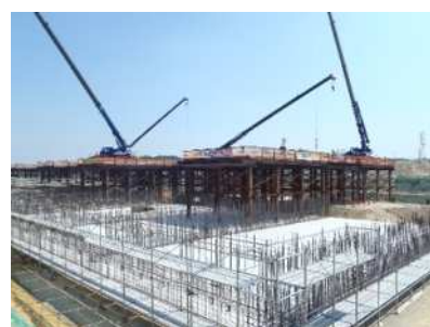
耐震化状況（豊野浄水場）
