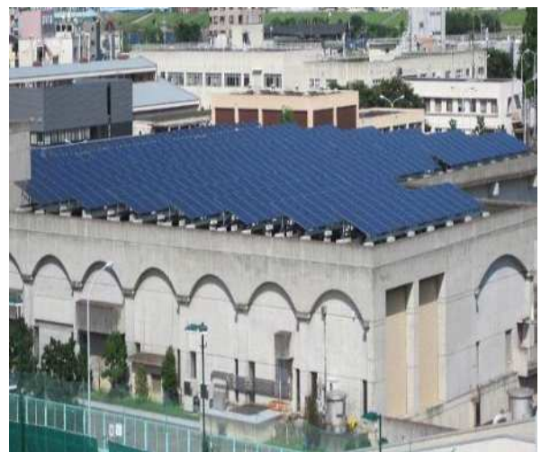
【高度浄水処理棟】
