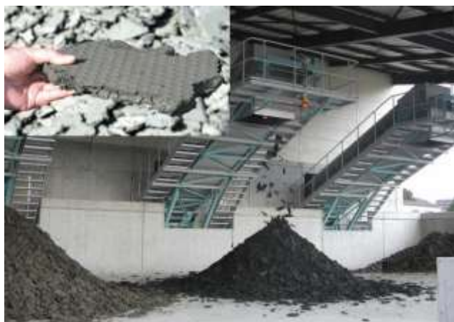
【排水処理施設】
