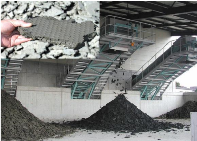
【排水処理施設】
