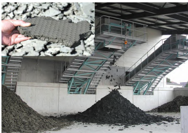
【排水処理施設】
