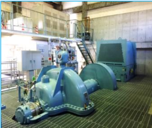
回転速度制御設備を導入した ポンプ設備
