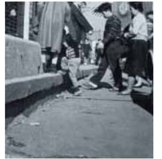
地盤沈下により陥没した道路
