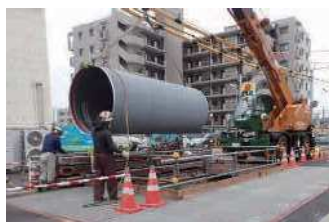
管路の耐震化工事(箕第1送水管)
