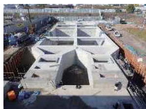
取水施設の耐震化工事(楠葉取水場)
