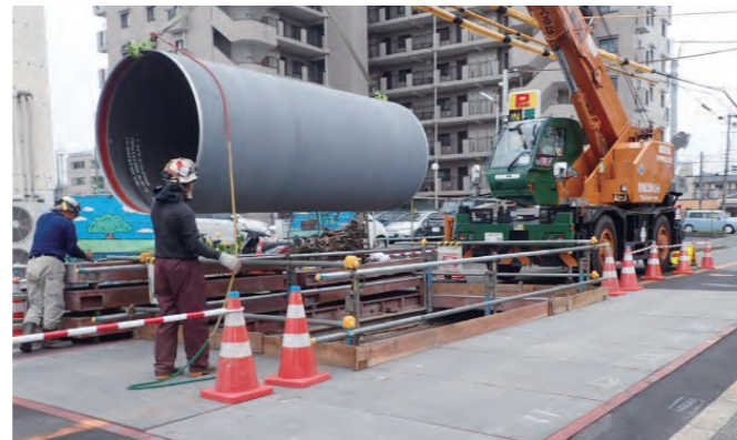
■ 図 大口径管路の更新状況 (PIP工法)
