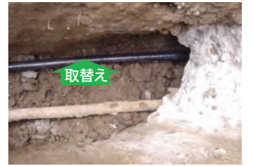
鉛給水管の取替え
