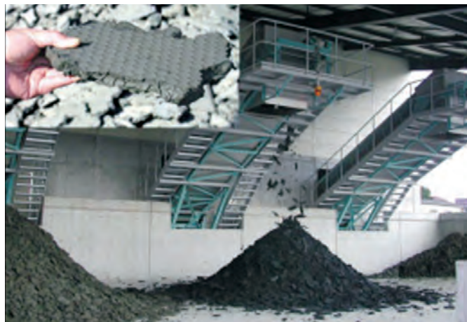
加圧脱水方式(庭窪浄水場)
