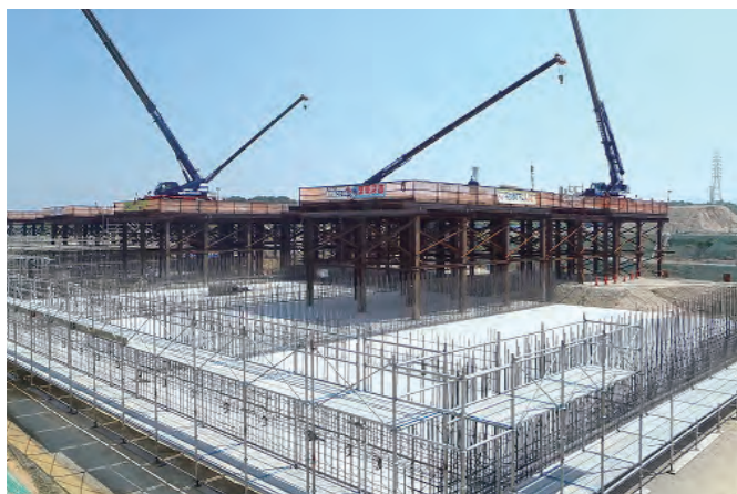
■ 豊野浄水場耐震化工事(凝集沈澱池)
