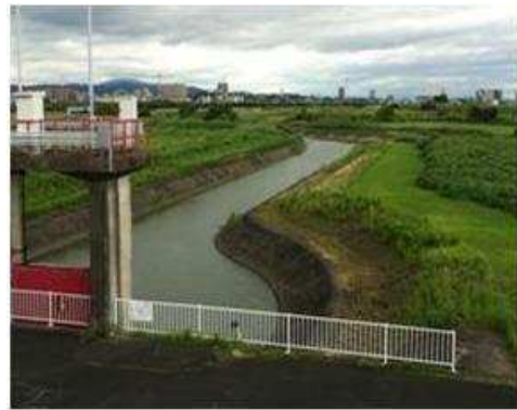
図-1 A ポンプ場放流水路（雨天時）
